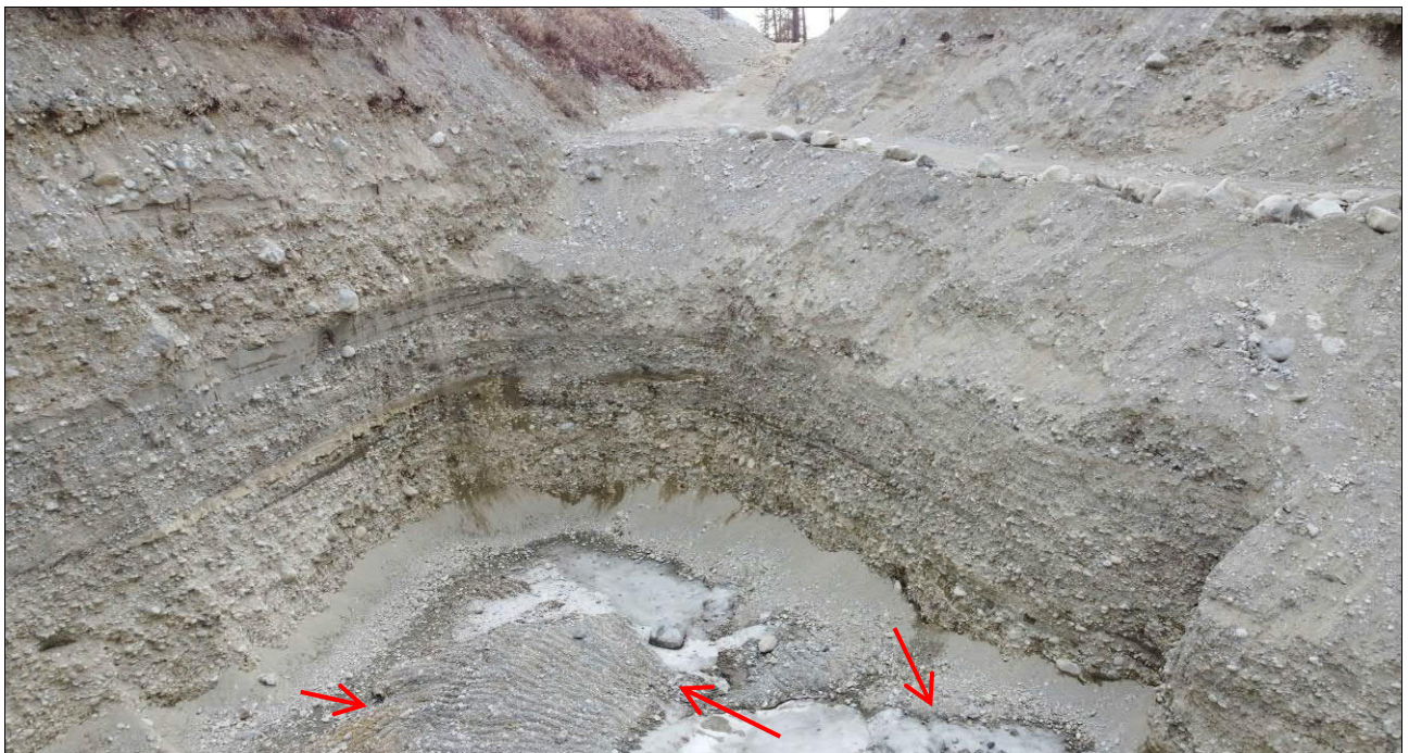
Abbildung 4-3: Fels im Bereich des Materialabbaus. Die Kratzspuren (➔) des Baggerlöffels auf dem Felsen sind gut erkennbar. Foto 19.11.2024.
