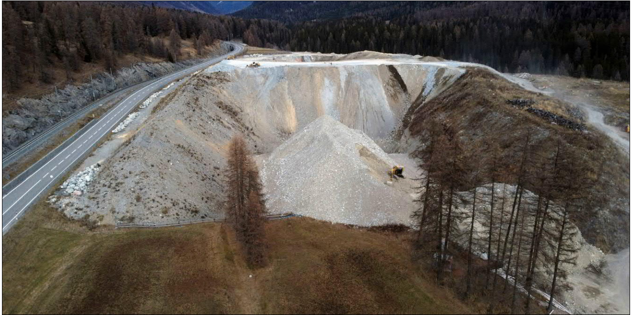
Abbildung 4-5: Kompartiment Typ A. Blickrichtung Zernez. Gemäss bewilligten Schütthöhen müsste der Trenndamm im letzten Drittel in Richtung Kantonsstrasse ca. 12 m tiefer liegen. Ebenso werden die bewilligten Schütthöhen entlang der Kantonsstrasse leicht überschritten. Foto 19.11.2024.
