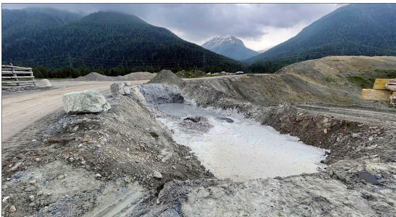
Abbildung 1-1: Schlammdepot. Absetzbecken zur Trocknung von angeliefertem Material, welches zu feucht für eine direkte Deponierung ist. Foto 14.06.2024.
